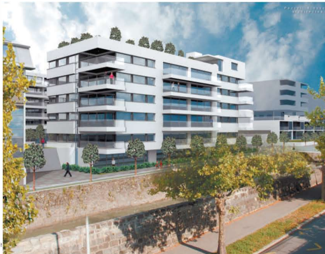
HABITAT Le projet immobilier, en place des Ateliers de constructions mécaniques de Vevey, s'inscrit dans le renversement de tendance qui amène les gens à revenir en ville, après leur avoir préféré la campagne.
